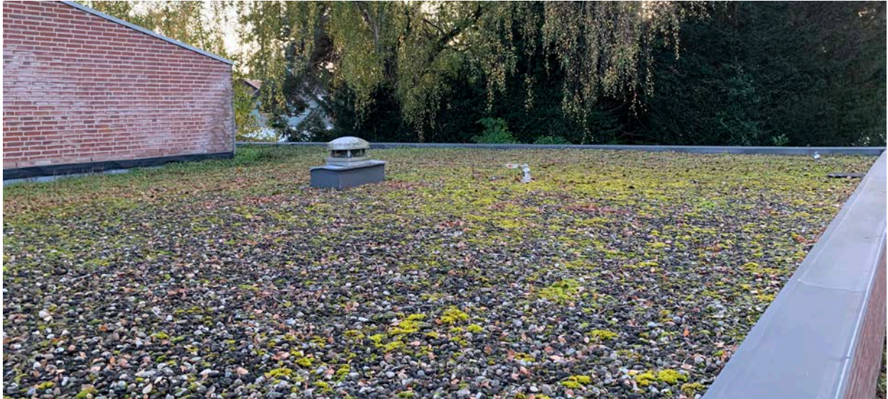
Figuur 8 | Mosvorming en begroeiing van het dak kan duiden op veel water.
