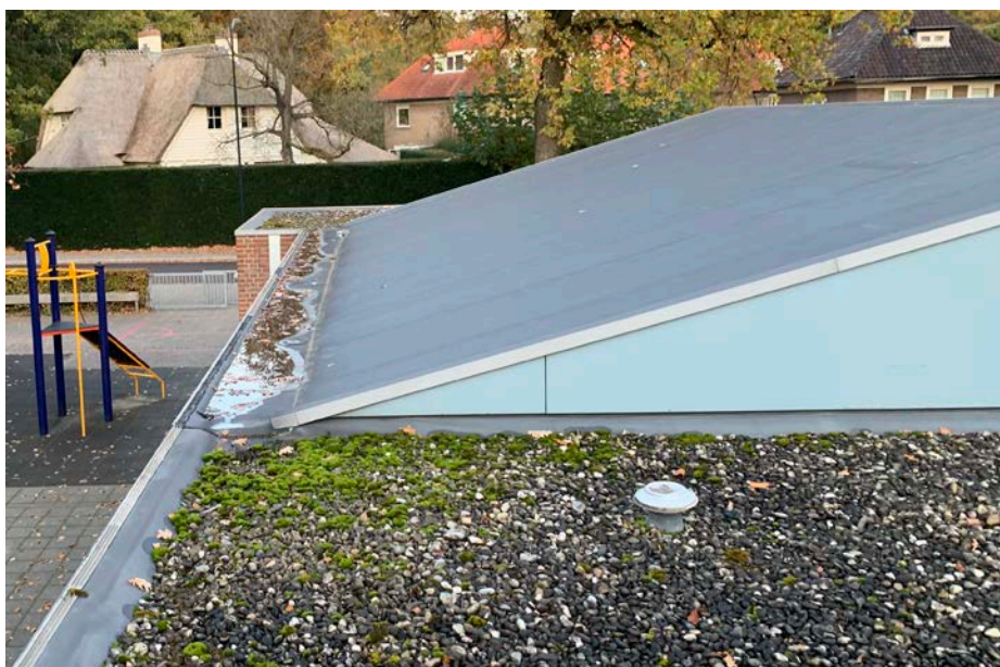
Figuur 7 | Water in goot, geen noodoverstorten aanwezig. Op vlakke delen grind.
